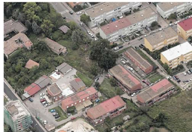
foto stato di fatto
